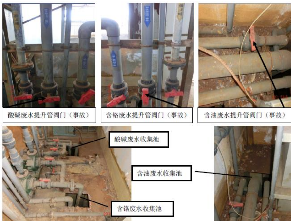
图 5.2-1 废水处理应急阀门
